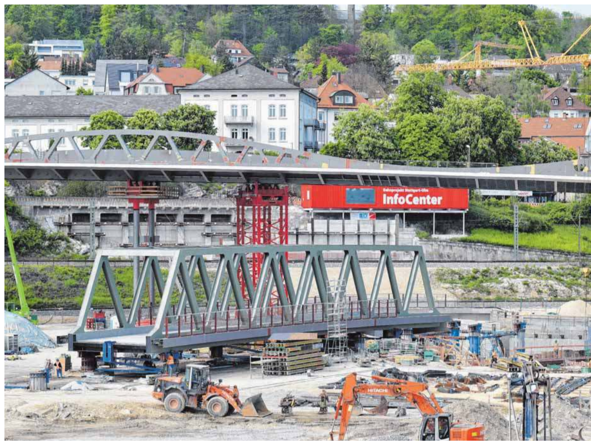
Die neue Eisenbahnbrücke im Ulmer Hauptbahnhof für das Gleis Richtung Aalen im Verschub. Über der Fachwerkbrücke deutlich zu erkennen: Die Brücke für die künftige Straßenbahnlinie 2. FOTO: HECKMANN
